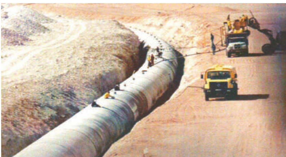
Рис. 2. Трубопровод в процессе строительства
