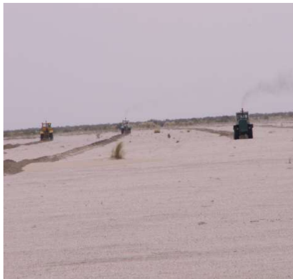
Рис. 2. Устройство песконакопительных борозд
