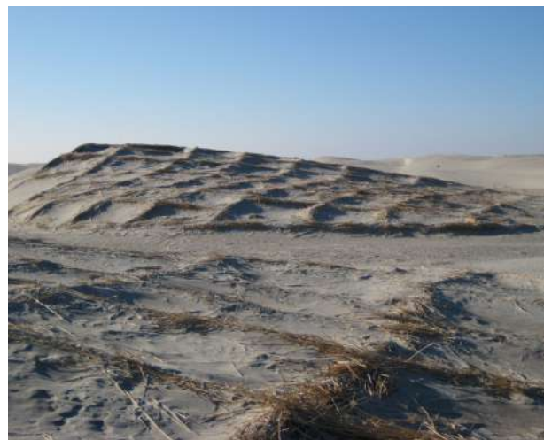
Рис. 3. Устройство механической защиты на пологоволнистых и барханных песках
