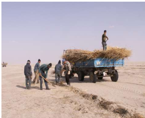
Рис. 3. Устройство механической защиты на пологоволнистых и барханных песках
