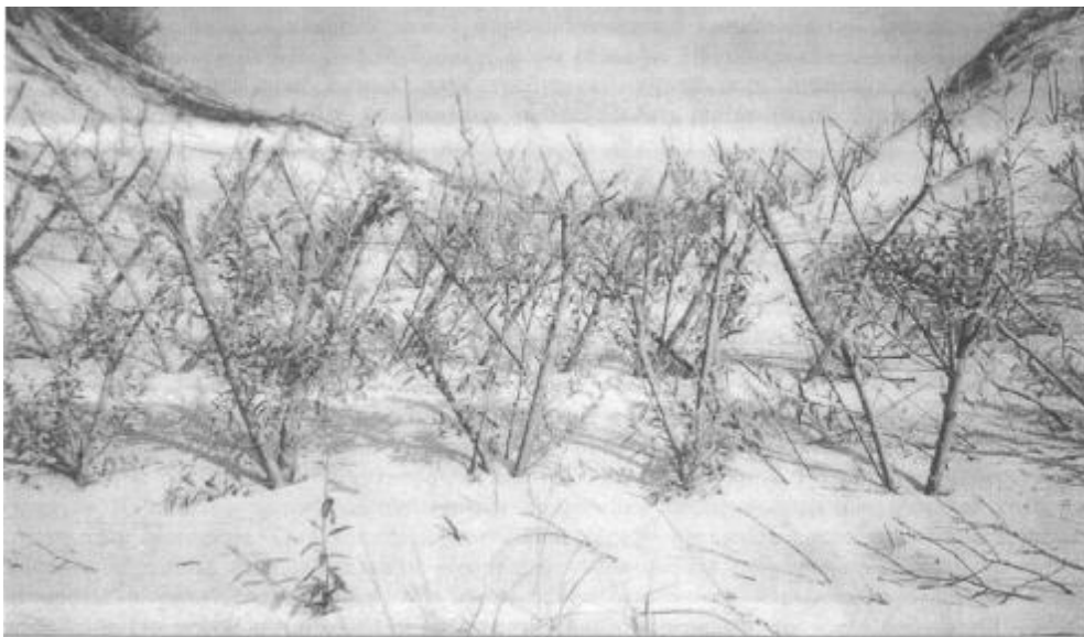
Рис. 1. Ажурная защита из ивовых ( Salix sp. ) кольев для восстановления разрушенных в результате абразии и дефляции участков авандюны (коридор выдувания).
